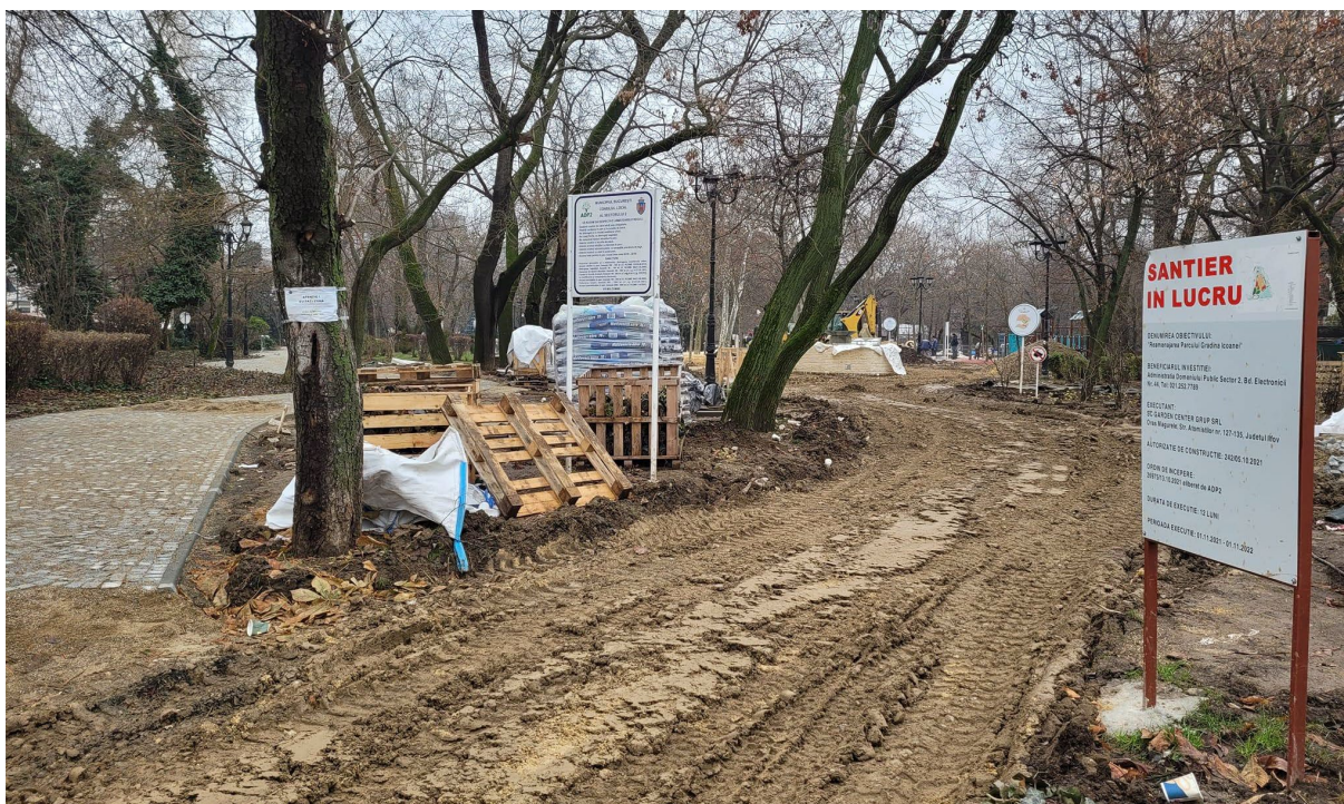
Fig. 2 - Exemplu referitor tasarea solului prin depozitarea materialelor de construire pe zona unde se află rădăcinile arborilor
